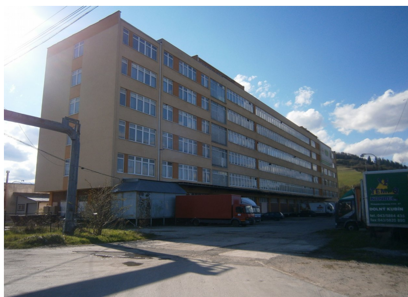
Nákladové rampy malé montáže ze zadní části objektu. Dnes zde sídlí spediční firma, zbytek je zřejmě prázdný
