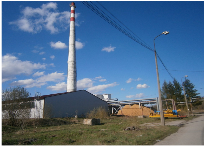
Kotelna dodnes funkční – musí být, zásobuje teplem sídliště v Nižné a Tvrdošíně
